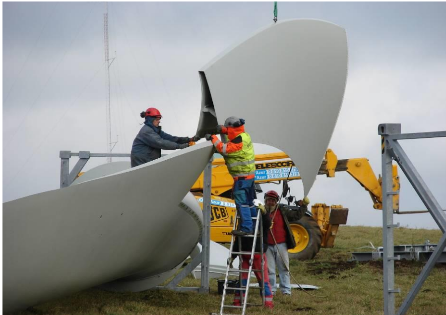
Personnels intervenants en phase de chantier (source Valeco)
